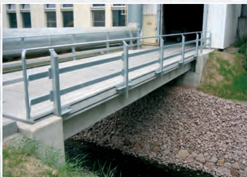
Most z elementów prefabrykowanych
