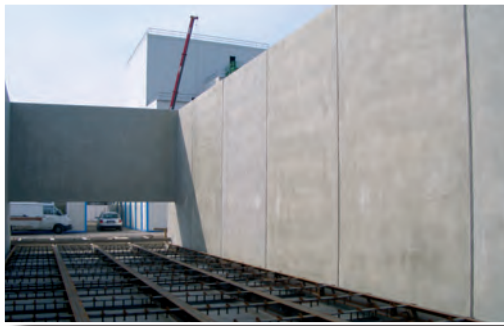
Instalacja do kruszenia do elektrowni spalającej drewno
