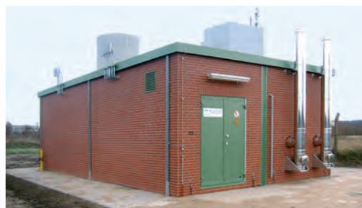
Stacja sprężania gazu
