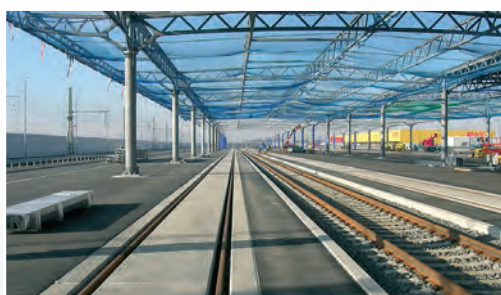
Plac przeładunku kontenerów
