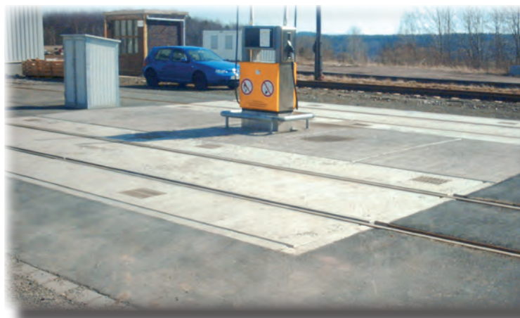
Korytko torowe z przejezdnym pokryciem betonowym
