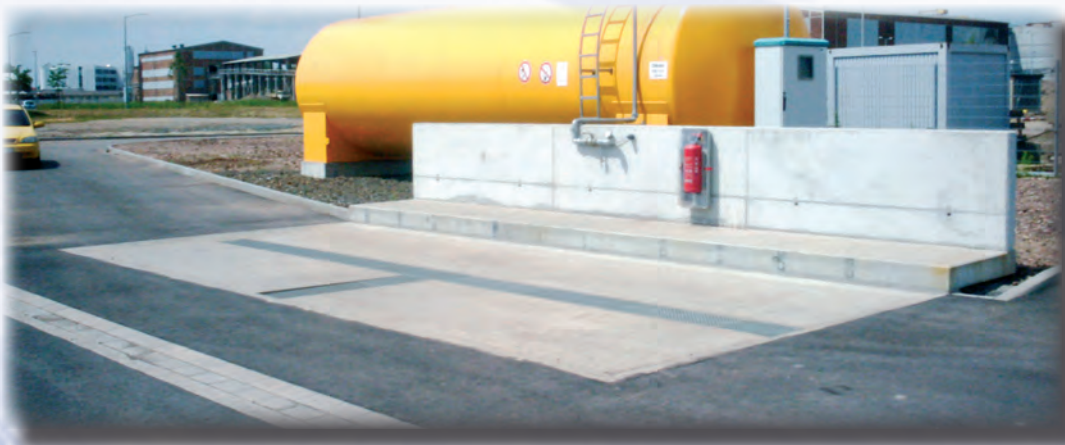
Zakładowa stacja benzynowa
