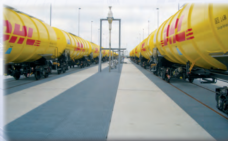
Powierzchnie odprowadzające ciecz do wyladowywania ropy lotniczej (Fracht lotniczy DHL lotnisko Lipsk/Halle)
